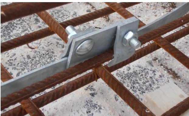
(Συνδετήρας τύπου II θεμελιακής ταινίας με οπλισμό κωδ.379)
