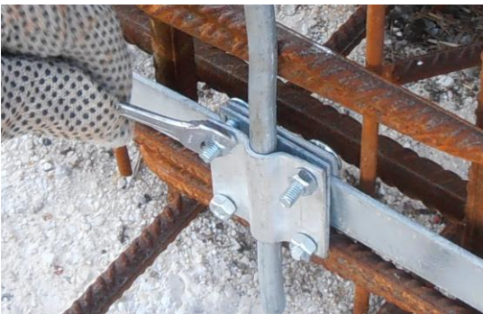
(Διακλαδωτήρας θεμελιακής ταινίας 30x3,5mm με αγωγό Φ8-12mm κωδ.672)
