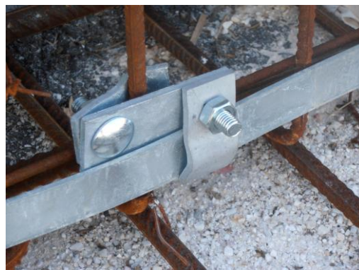
(Συνδετήρας τύπου II θεμελιακής ταινίας με οπλισμό κωδ.379)
