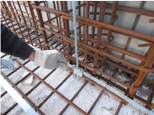
(Διακλαδωτήρας θεμελιακής ταινίας 30x3,5mm με αγωγό Φ8-12mm κωδ.672)
